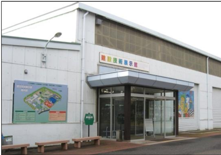
建設技術展示館
