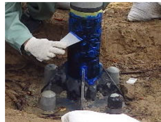
シート貼付け
