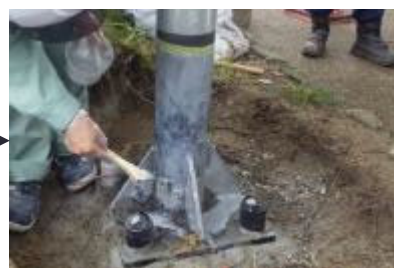
プライマー 塗布
