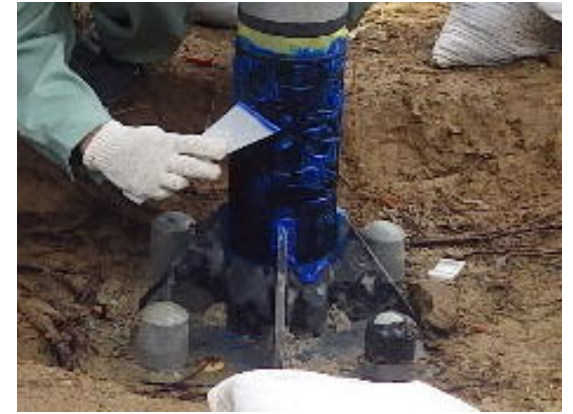
シート貼付け
