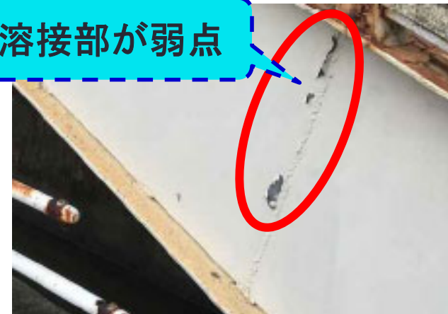
鋼板溶接(表面)
