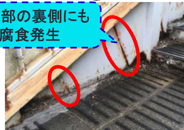
鋼板溶接(裏面)
