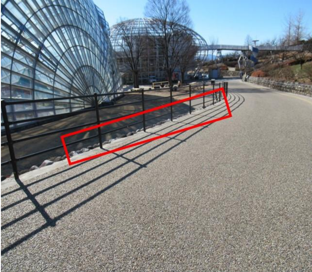
園内の転落防止柵地際に施工
