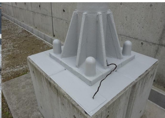
奈良県 鉄道 鋼管基脚部
