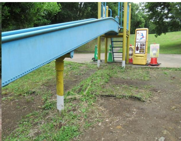
神奈川県 公園内 滑り台 支柱 2018年施工
