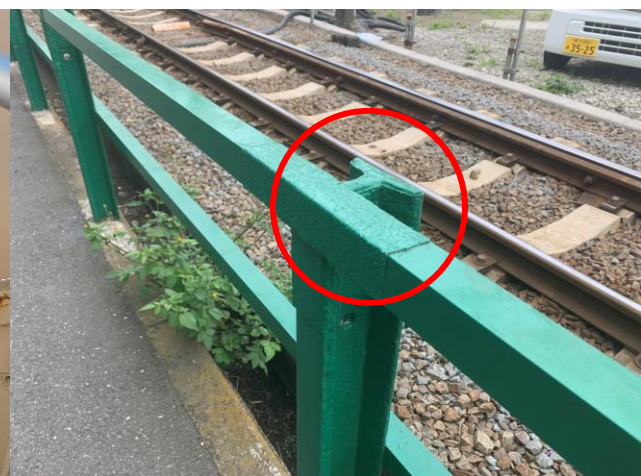
神奈川県 鉄道 防護柵 2022年施工 柵塗装を上塗り
