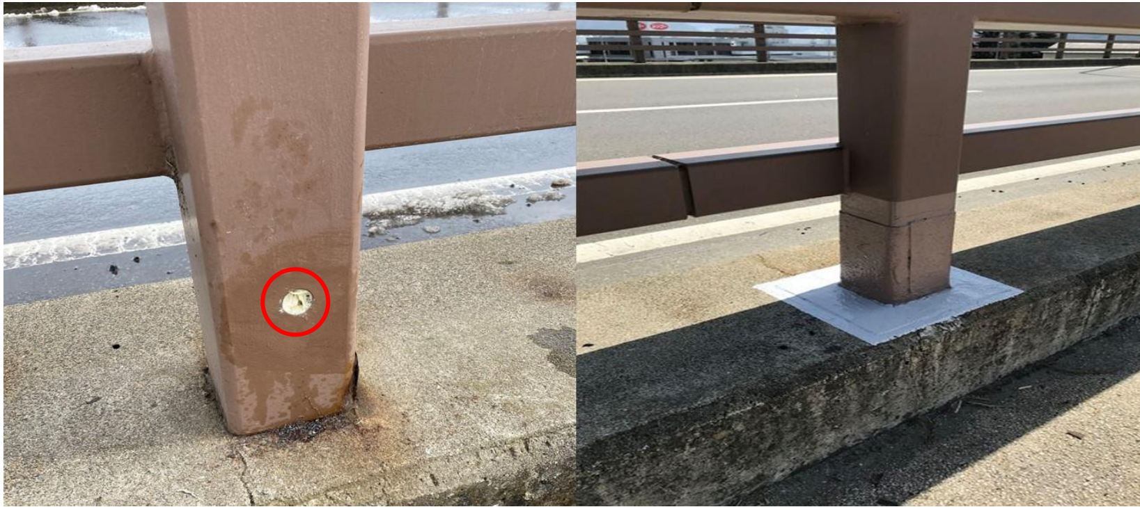
ウレタンの注入完了
