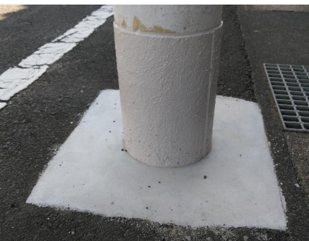
島根県 神社 鳥居保護用の門柱 2020年施工 犬のマーキング対策
