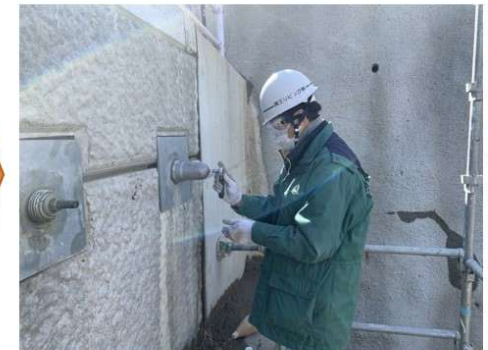
（施工後）頭部キャップ取付け（防錆剤を含む）
