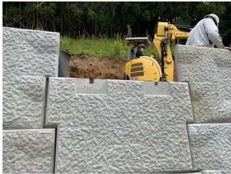
① 下側壁面材の設置
