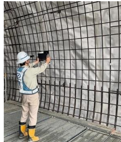
山岳トンネル
