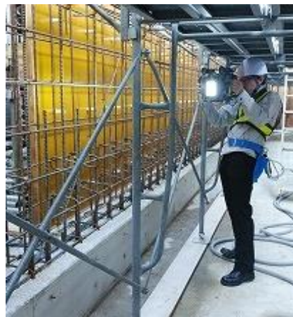
開削トンネル
