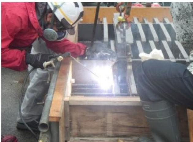
アンカー筋と通し筋の溶接状況
