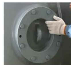
既設ポンプの点検窓枠
