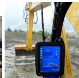
ICT建設機械の施工
