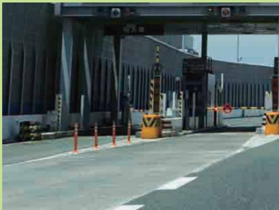
半たわみ性舗装(料金所)
