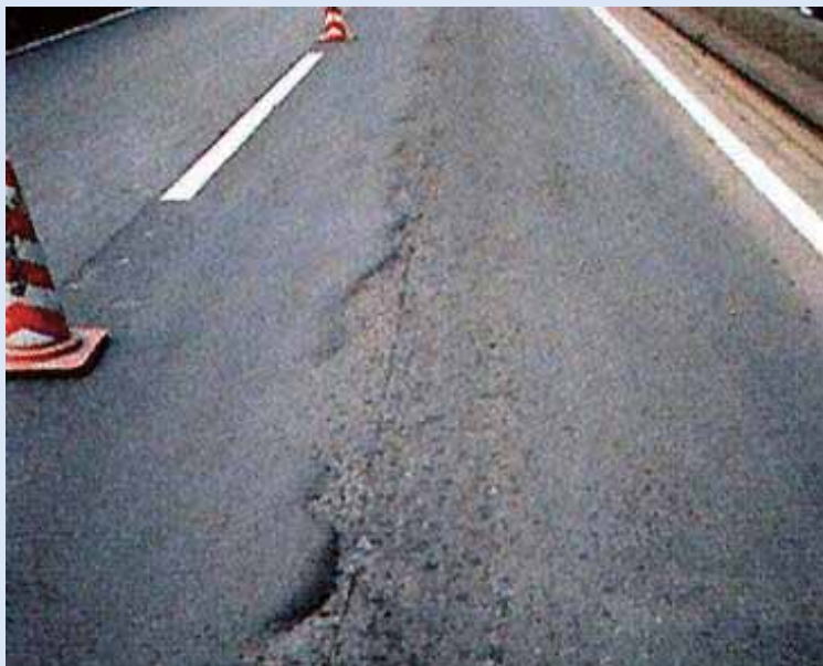
既設路面状況
