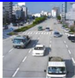
コンクリート舗装
