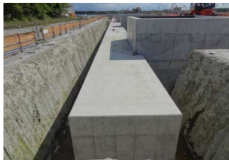
図3 構造物の完成
