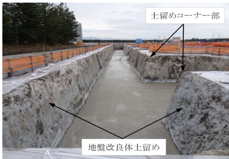
図2 土留め壁の完成
