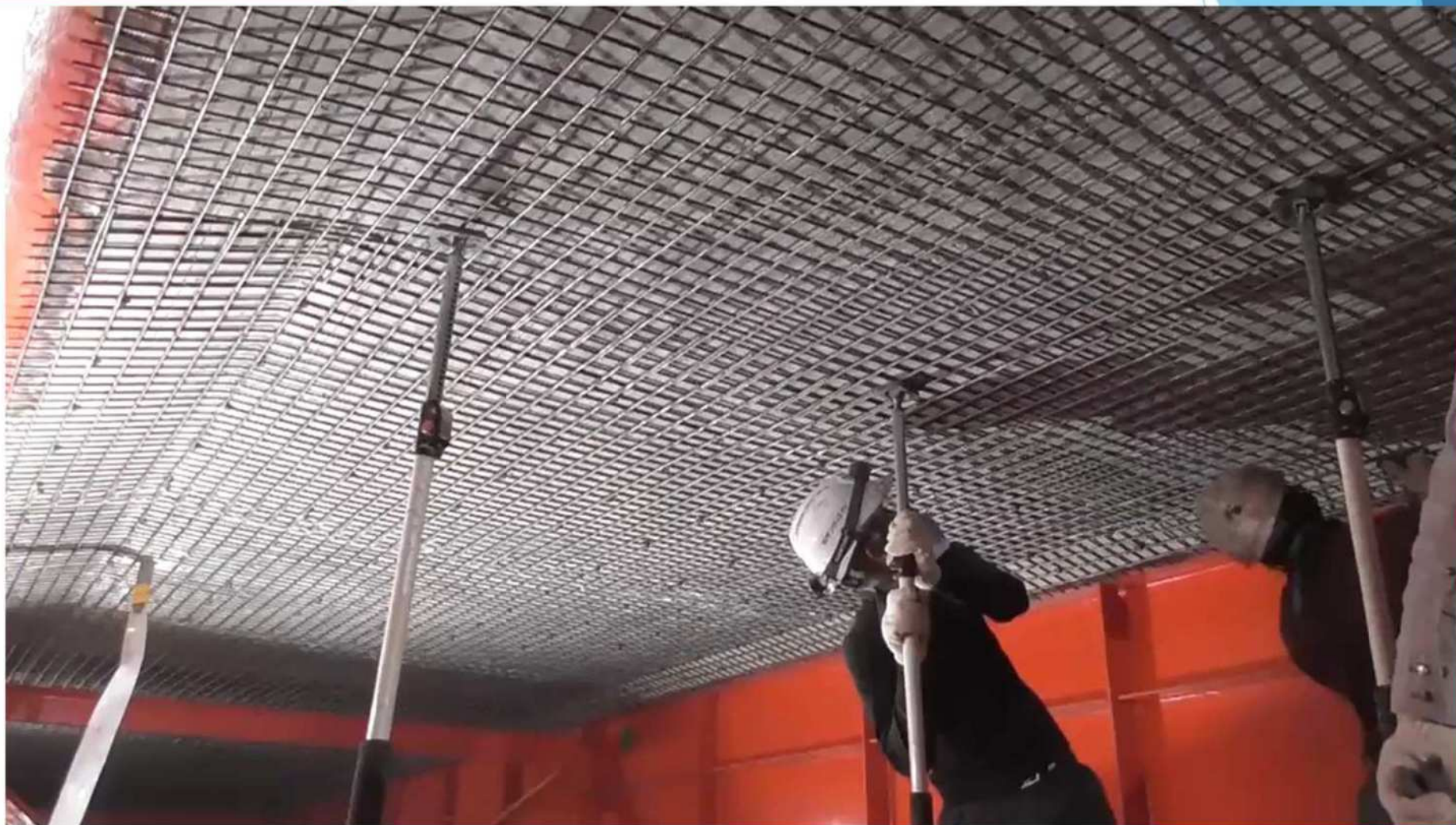
格子状溶接鉄筋 固定状況
