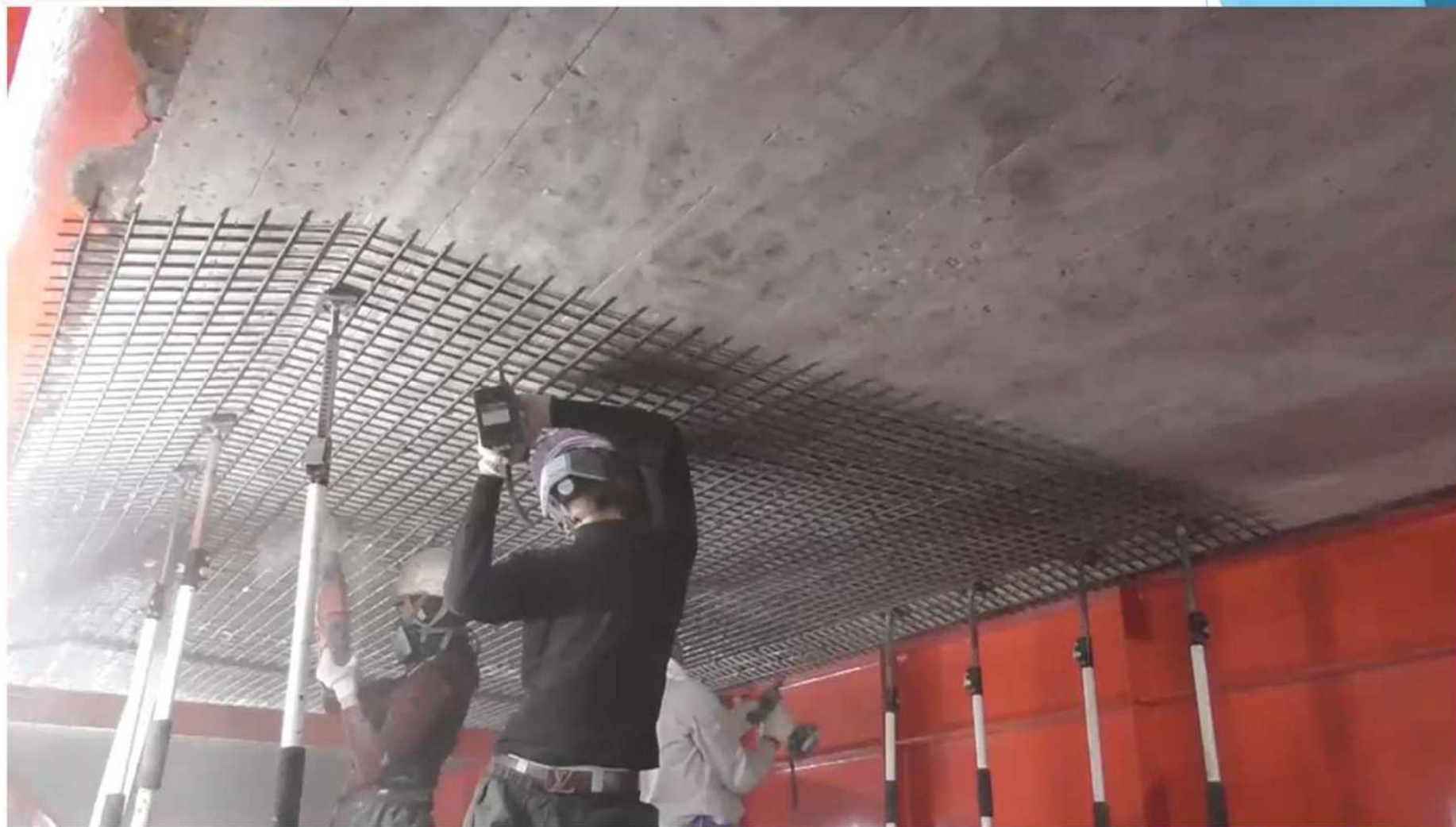
格子状溶接鉄筋 固定状況
