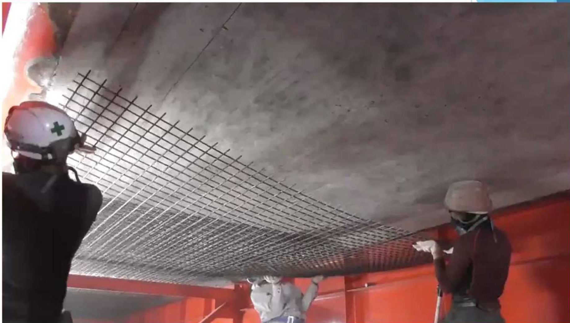
格子状溶接鉄筋 固定状況
