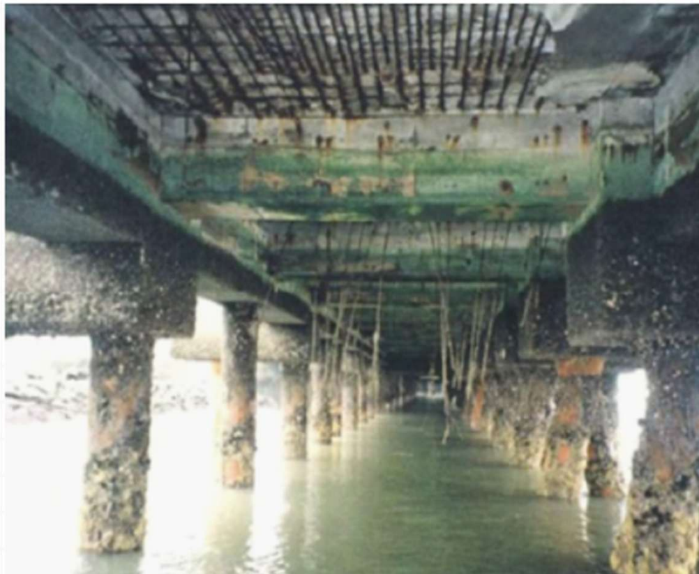
劣化事例①…港湾施設の棧橋上部工
