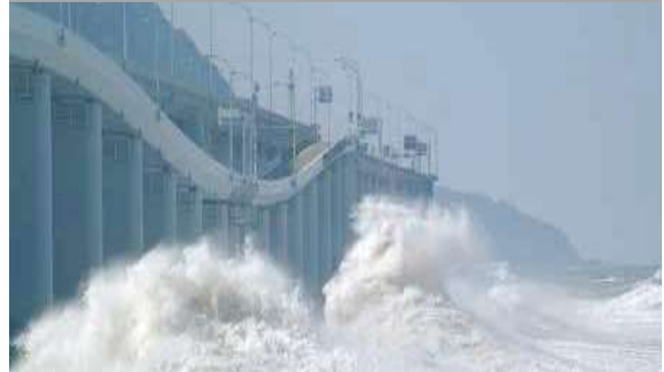
塩害をうける コンクリート構造物
