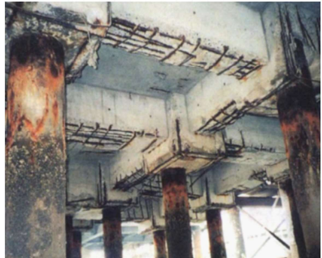
劣化事例①…港湾施設の棧橋上部工
