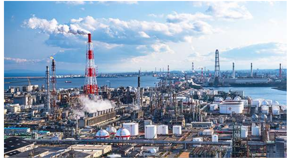
発電所・化学プラント等 設備
