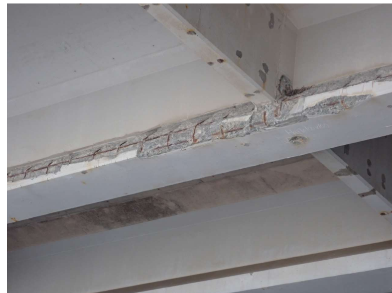
劣化事例②…コンクリート橋梁（鉄道・道路）
