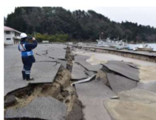
被災状況(港湾)の調査
