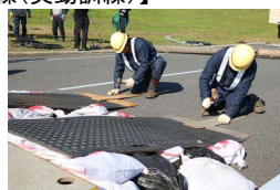
土のうを積み上げるなどにより道路段差を解消
