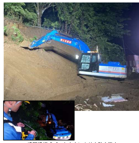
遠隔操縦式バックホウにより土砂を撤去
