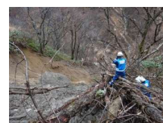
被災状況(斜面崩落)の調査
