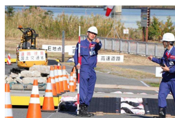
道路啓開後の道路の状況等を職員が確認
