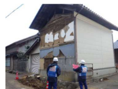
被災状況調査 (被災建築物応急危険度判定)
