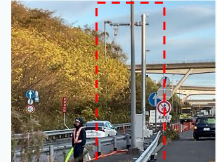
実証実験機器(左:車両検知センサ、右:情報提供施設)
