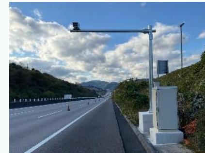
実証実験機器(左:車両検知センサ、右:情報提供施設)
